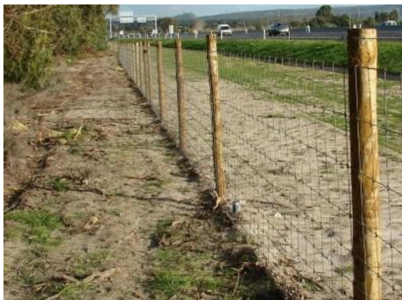
Photo 61 : Exemple de clôture avec grillage mouton et piquets en bois
