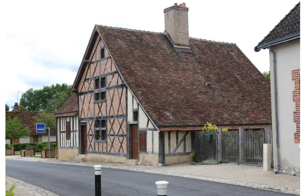
Photo 46 : La maison à pans de bois dite La Forge s'insère dans la trame bâtie du bourg de Veilleins
