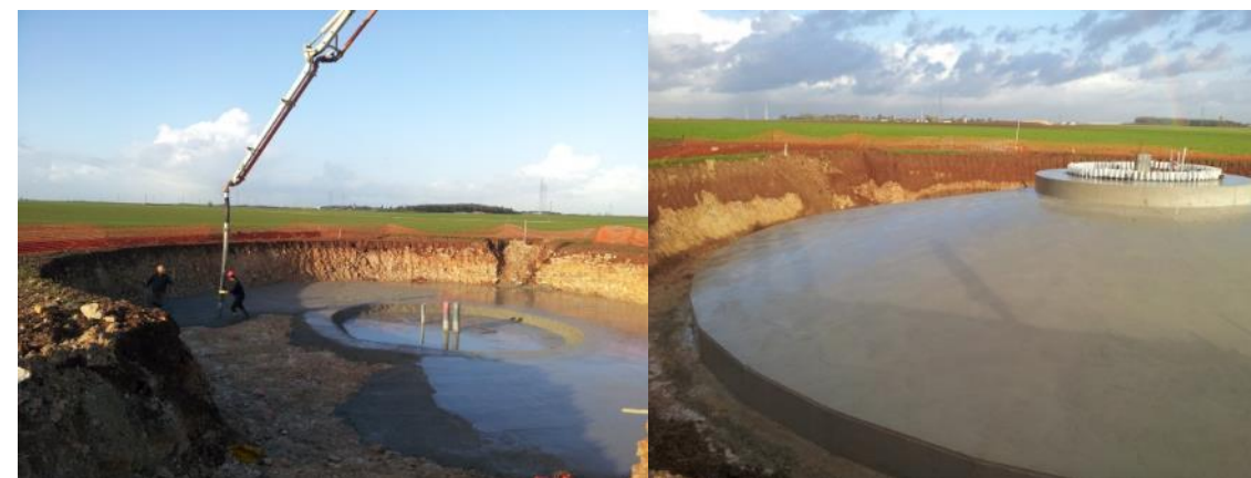
Chantier éolien – Novembre 2013
