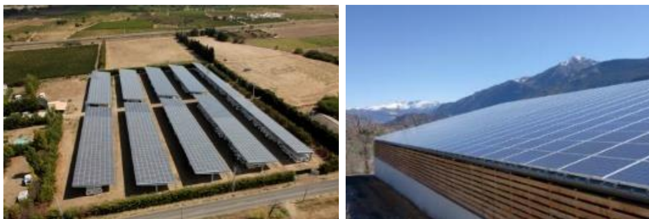
Photo 3 : Exemples d'installations photovoltaïques exploitées par JPee : les ombrières du Bosc (à g.) et la centrale d'Embrun (à d.)
