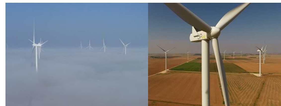
Parc éolien – Novembre 2014
