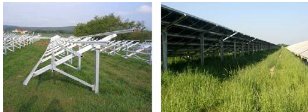
Photo 1 : Exemple de structures portantes, reposant sur profilés acier sans fondation béton (Total Quadran)
