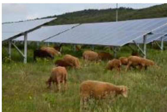
Photo 9 : Exemple d'une installation TOTAL QUADRAN permettant le pâturage ovin (Source : AGROSOLUTIONS, 2020)
