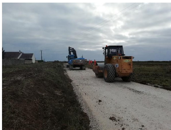
Photo 6 : Vues sur des pistes en construction (Total Quadran)
