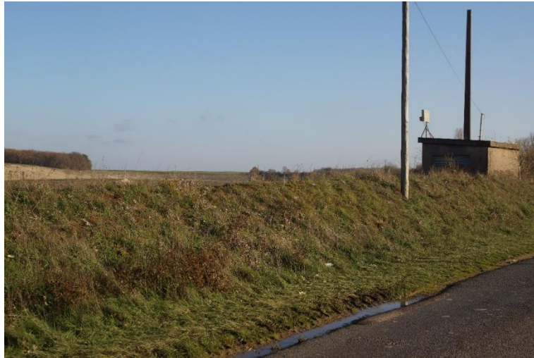
Vue sur le talus bordant partiellement la RD137
