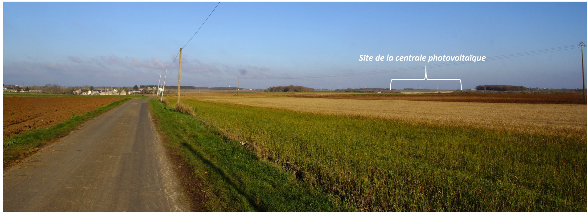
Distance du site : environ 1,5 km
