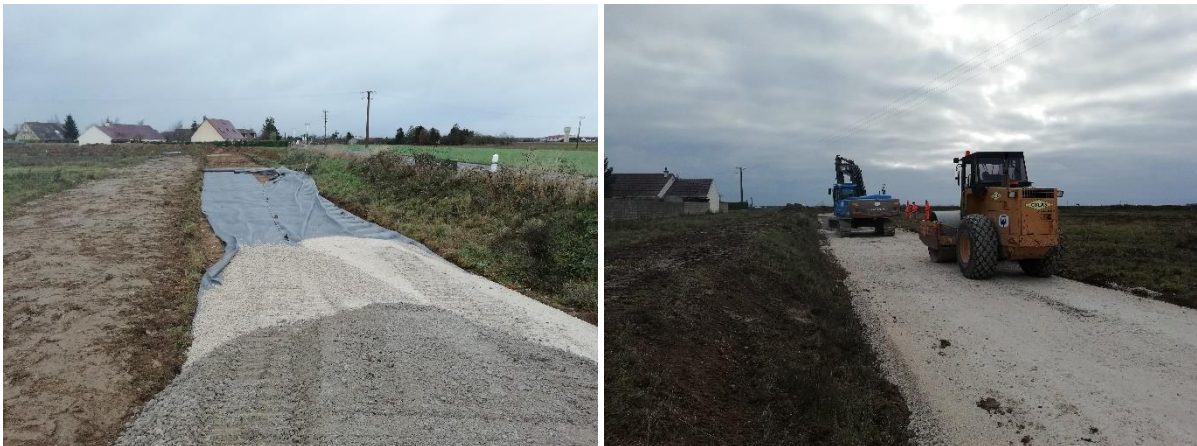
Vues sur des pistes en construction – Source Total Quadran
