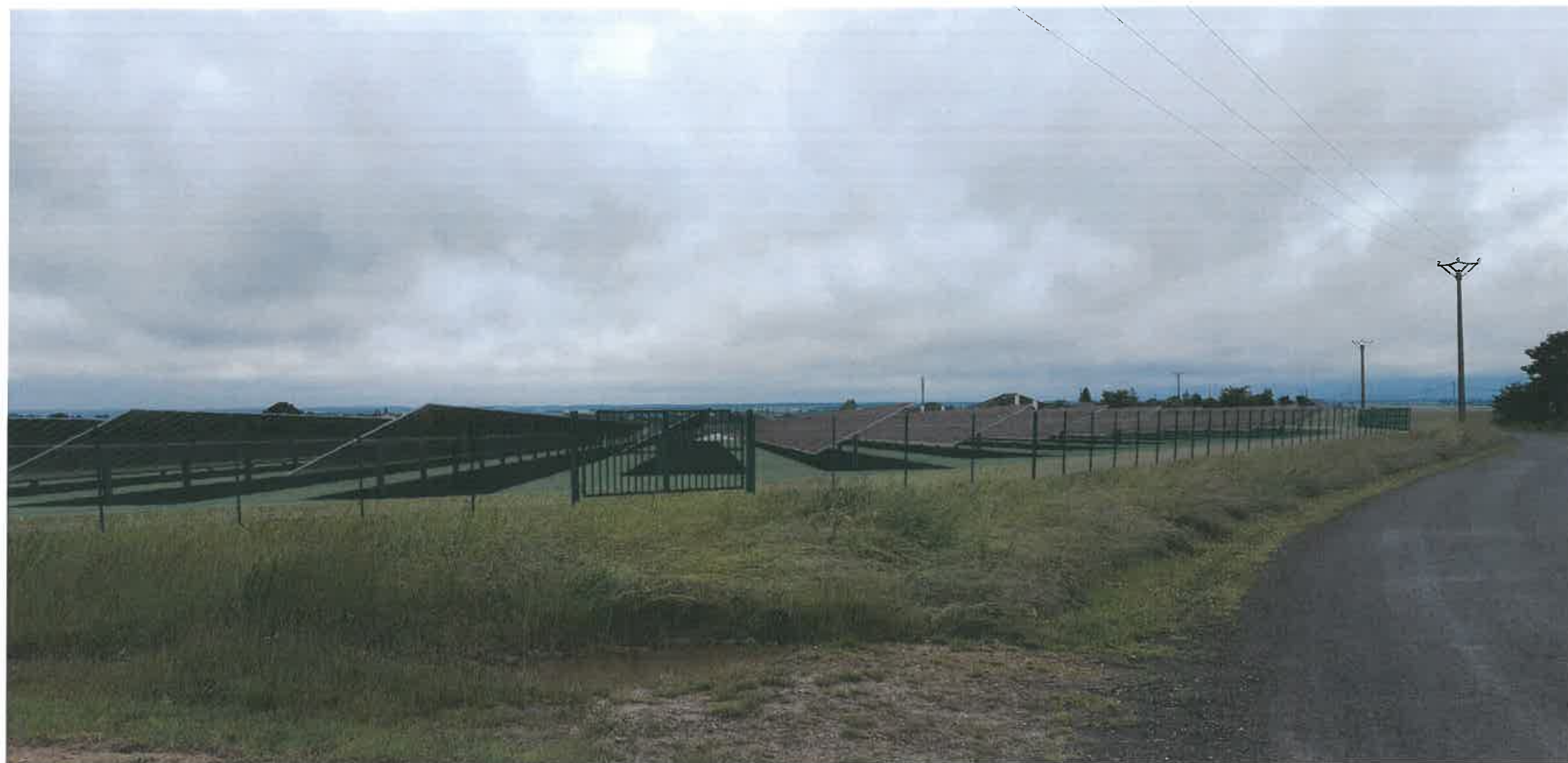
PV2 - Point de vue vers l'ouest du projet depuis le chemin communal au nord de ce dernier
