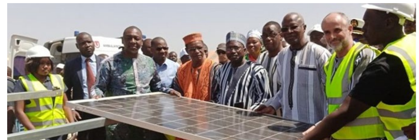
Figure 15 : Pose du 1er panneau de la centrale photovoltaïque de Pâ – Burkina Faso – février 2020 (source : URBASOLAR, 2022)
