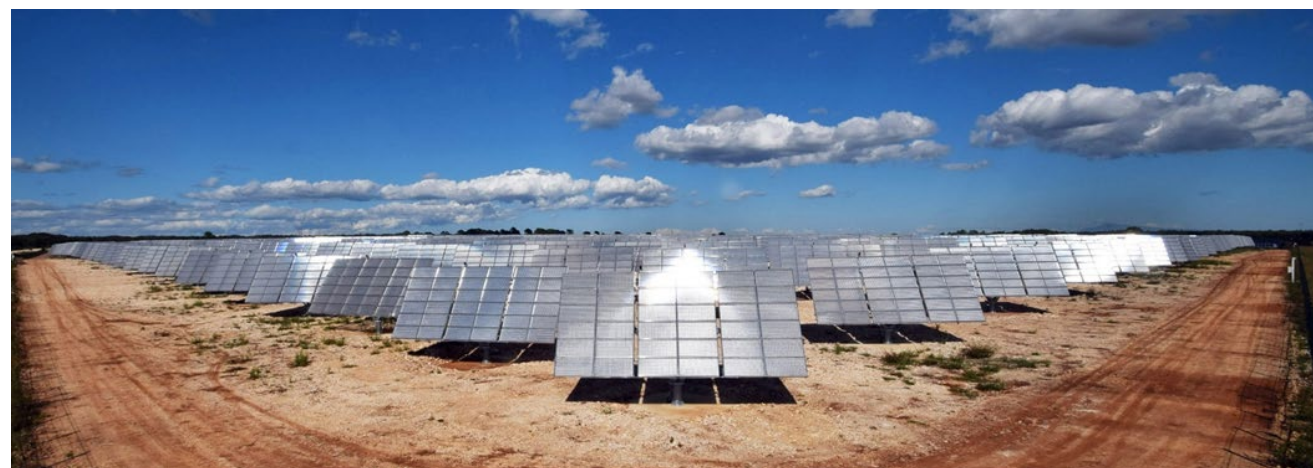
Figure 12 : Exemple d'installation du groupe URBASOLAR (source : URBASOLAR, 2022)
