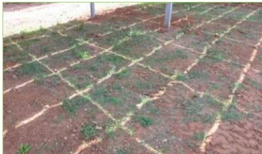
Photographie 58 – Aperçu de l'ombrage provoqué par les structures d'une centrale photovoltaïque ; notons la présence d'un développement végétal (source : ECO-STRATEGIE)
