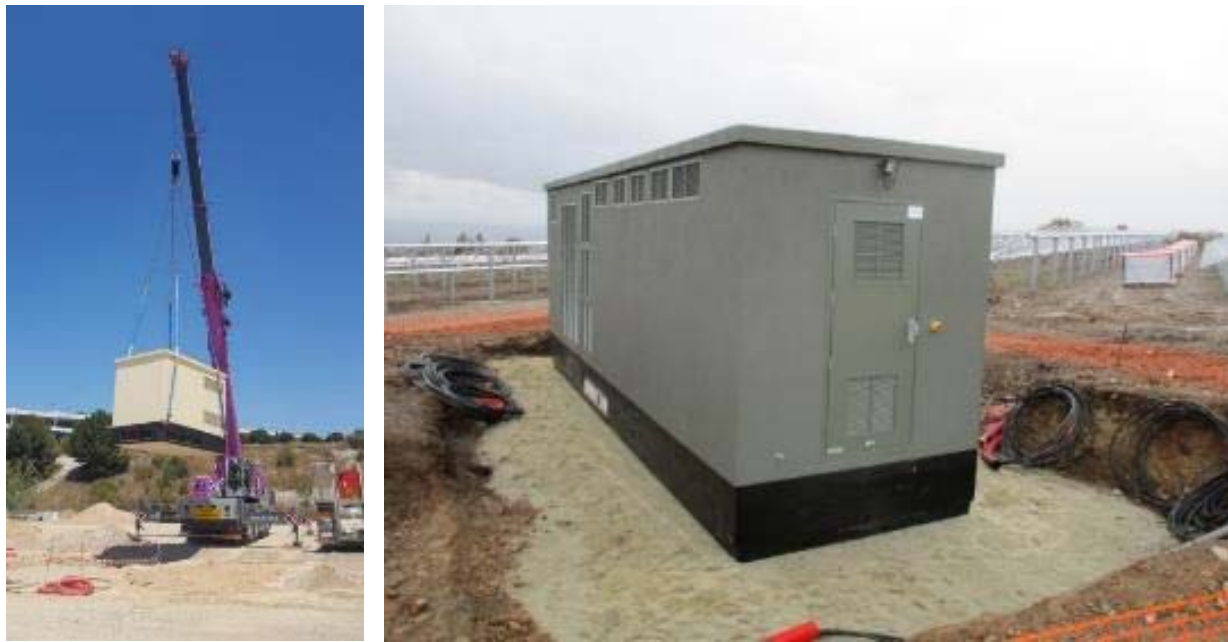
Photo 41. Installation d'un poste électrique
