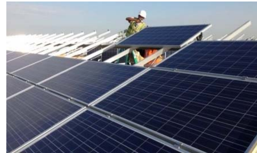
Photo 39. Exemple de mise en place des panneaux sur les structures
