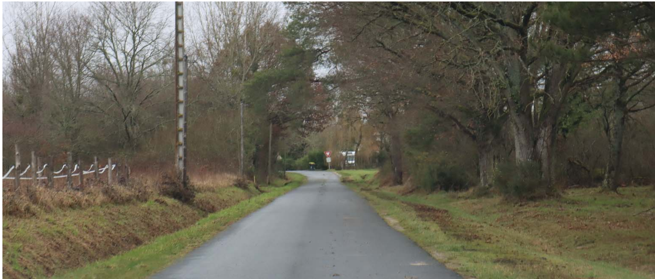
Photo 12. Route départementale D22 au niveau de Montrieux-en-Sologne
