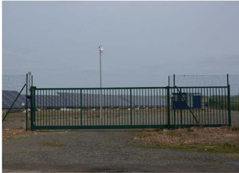
Photo 36. Exemple de portail d'accès
