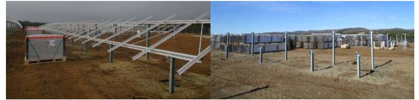
Photo 38. Assemblage des structures sur site
