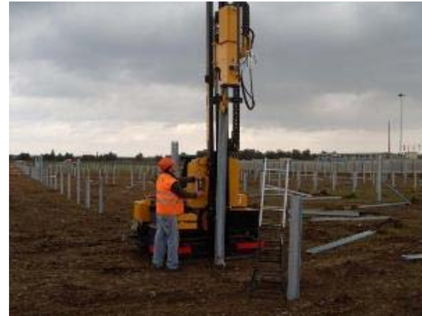
Photo 32. Exemple de fondation type pieux
