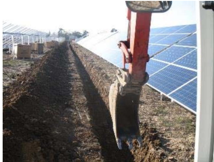
Photo 40. Exemple de tranchée entre deux tables photovoltaïques
