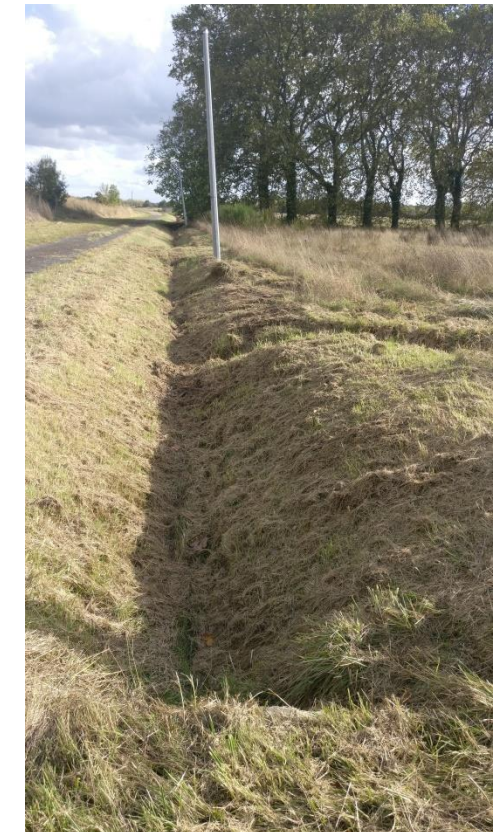
Photo 17: Fossé existant sur le secteur 2
