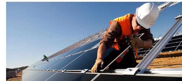
Photo 7 : montage de modules sur des supports fixes (Source : EDF Renouvelables)
