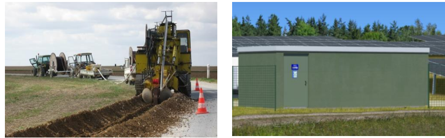
Photo 8 : Déroutage et pose des câbles (à gauche), exemple de poste de livraison (à droite) (Source : EDF Renouvelables)
