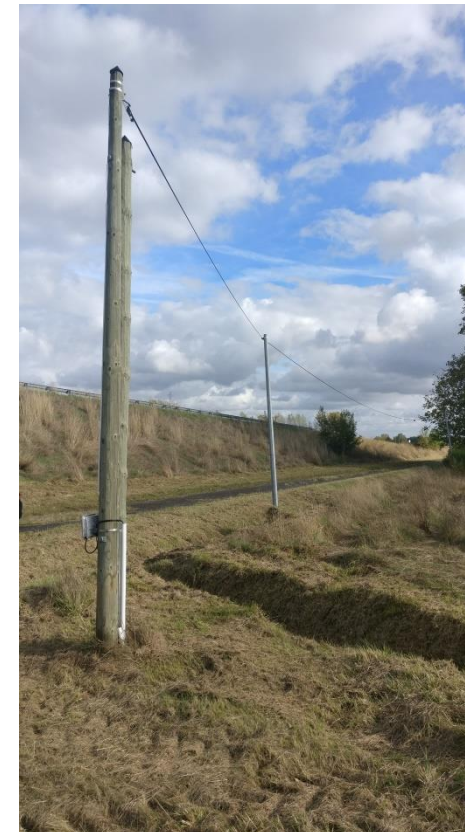
Photo 16: Fossé existant sur le secteur 2
