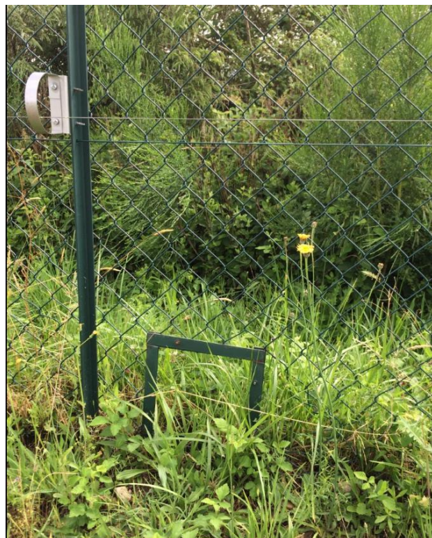
Figure 21 : Photographie de la clôture et du passage à faune (source : EDF-R)
