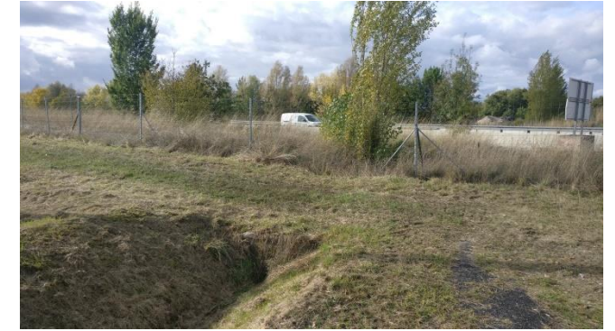
Photo 15: Fossé existant sur le secteur 2
