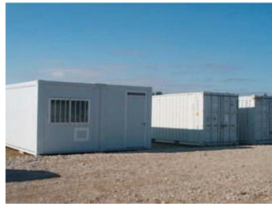
Photo 4 : Installation de la base-vie (Source : EDF Renouvelables)
