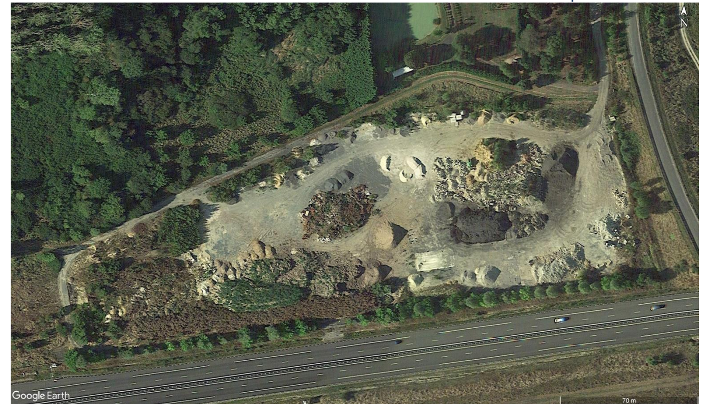
Photo 11 : Photo qui montre la topographie existante de la partie qui sera terrassée
