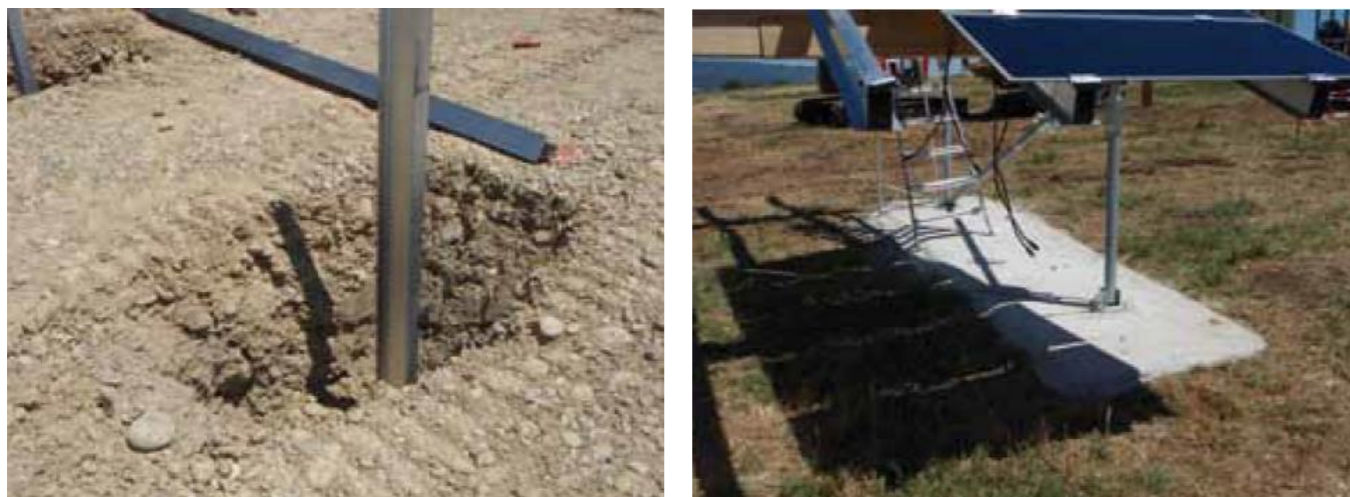
Photo 3 : Fondation avec pieux acier (à gauche) et fondation avec semelle béton (à droite)
