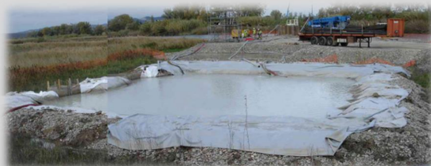
Figure 63 : Bassin provisoire de décantation des MES et autres polluants (Source photo : ADEV Environnement)
