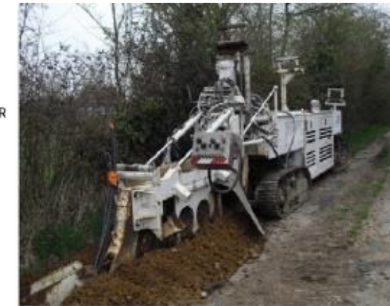
Photo 64 : Vue en coupe d'une tranchée et exemple de réalisation d'une tranchée de câbles
