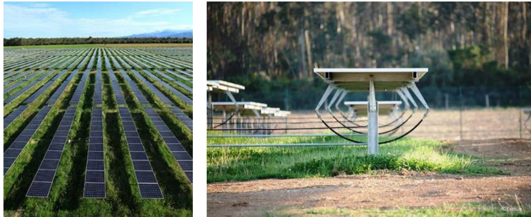
Photo 62 : Exemples de trackers mono-axe
