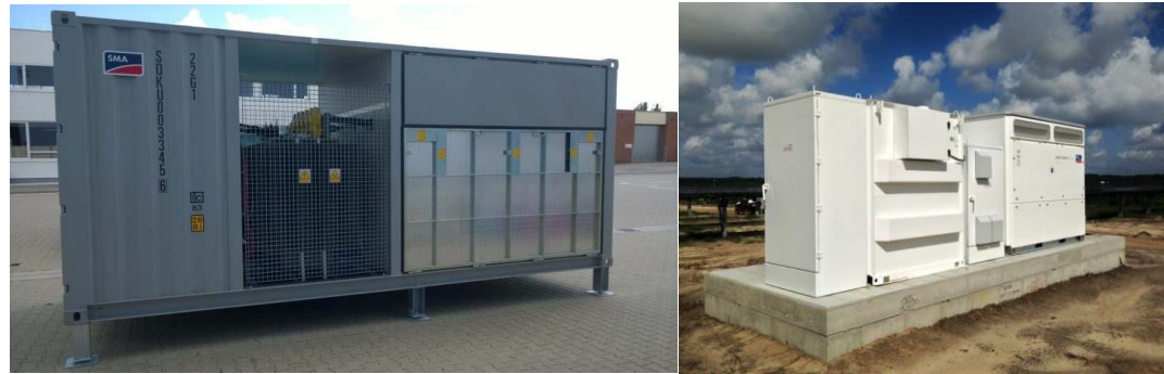
Photo 66 : Exemples de postes de transformation « container » ou « outdoor »
