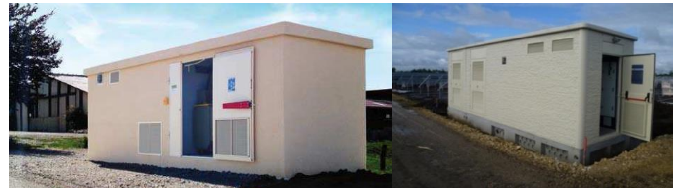
Photo 65 : Exemples de locaux techniques abritant les postes de transformation
