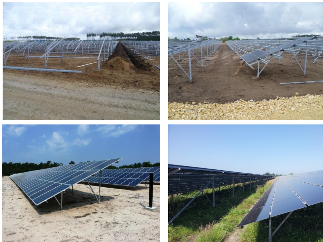
Photo 59 : Exemples de structures porteuses
