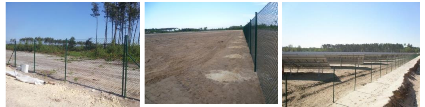
Photo 68 : Exemples de clôtures de sites photovoltaïques
