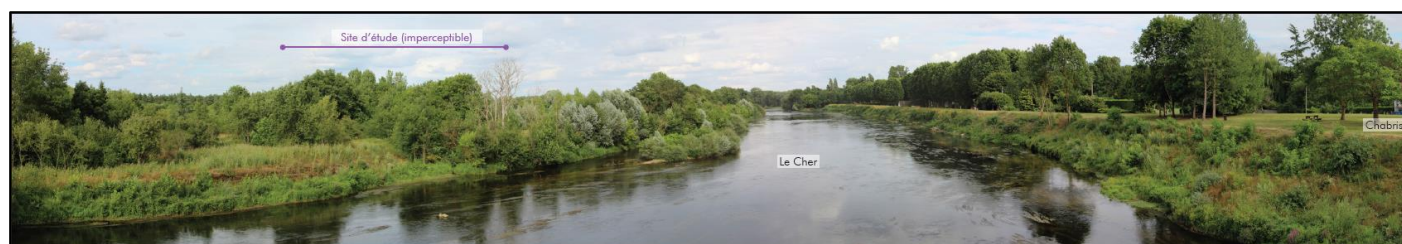
Vue vers le site d'étude au Sud-Ouest, depuis la D 128 sur le pont du Cher à l'entrée du bourg de Chabris Source : L'Artifex 2017
