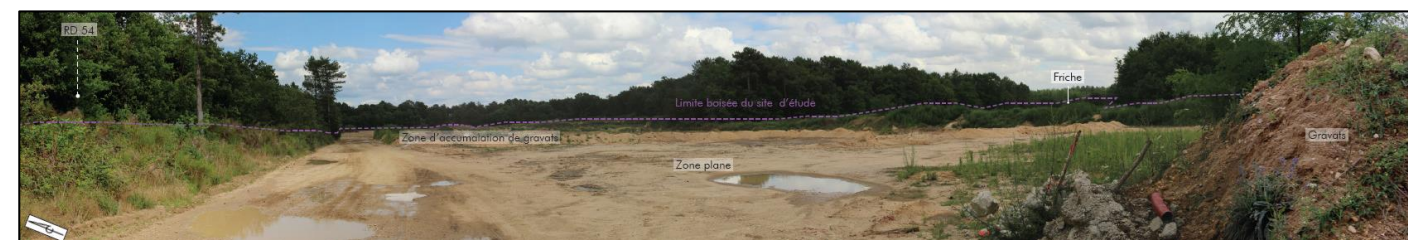
Vue depuis l'entrée du site, au Nord-Ouest, sur l'ensemble de la parcelle en cours de réaménagement Source : L'Artifex 2017
