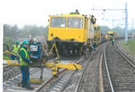
Longs Rails soudés sur traverses béton
