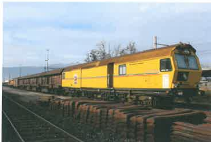
Train meuleur de rails (Scheuchzer S.A.)
