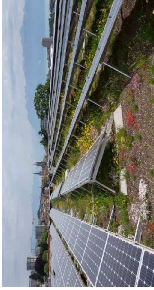
Figure 3 : En rafraîchissant les panneaux, les plantes améliorent le fonctionnement des installations photovoltaïques (source : http://www.lausanne.ch/thematiques/nature-parcs-et-domaines/politique-ecologique/toitures-vegetalisees/vegetation-et-panneaux-solaires.html )
