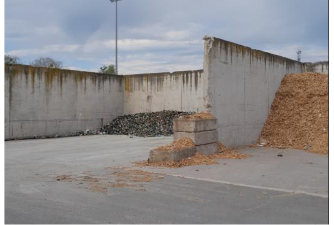
Zone de stockage bois et plastique
