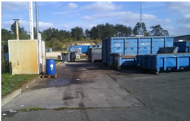
Aire de lavage
