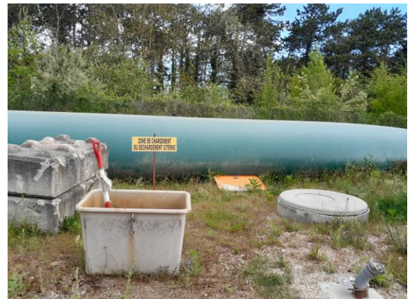
Emprise de la cuve de gazole enterrée + dépotage
