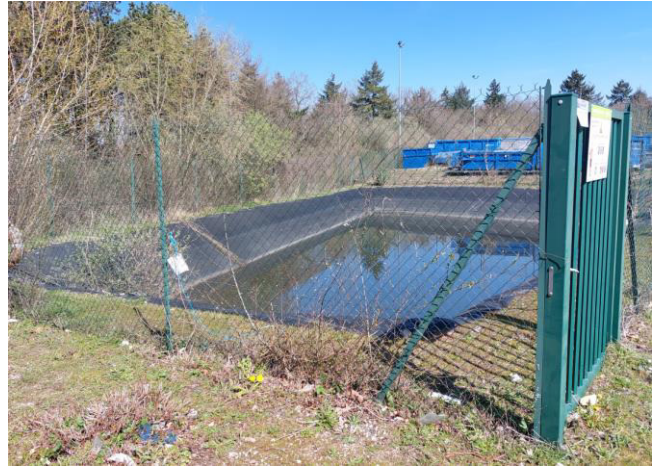
Bassin de reception des eaux pluviales (et de collecte des eaux incendies)
