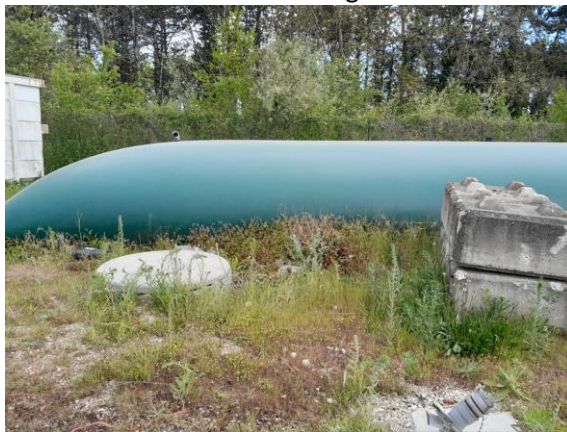
Emprise de la cuve de GNR enterrée + dépotage
