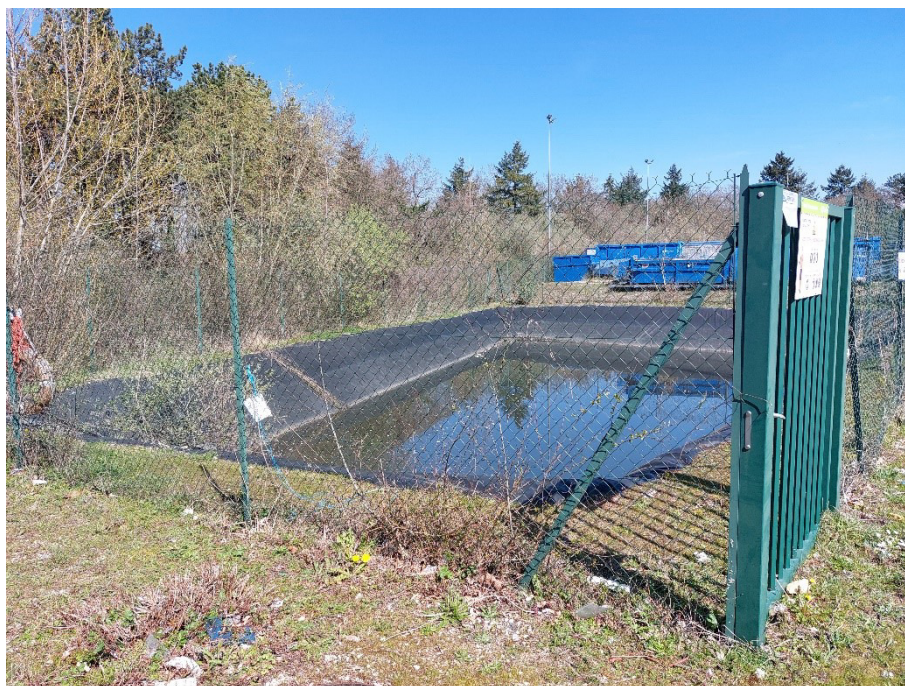
Bassin de collecte des eaux de ruissellement
