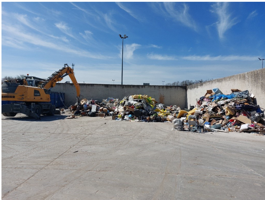
Alvéole de stockage externe, parois béton hauteur 5 m
