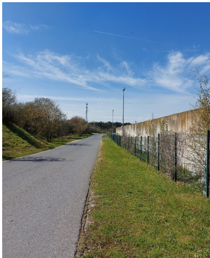
Clôture Sud et mur béton des alvéoles
