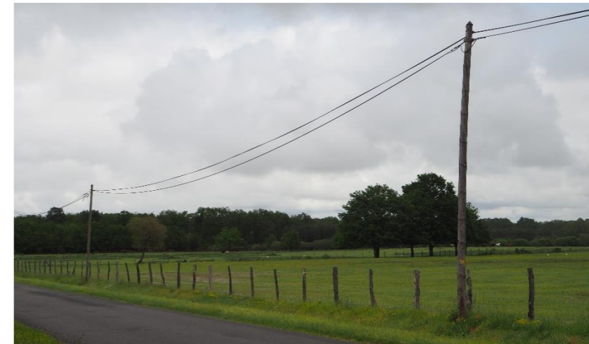
Photo 37 : Le réseau aérien Orange le long de la route qui accède au hameau les Barres (source : AEPE Gingko)
