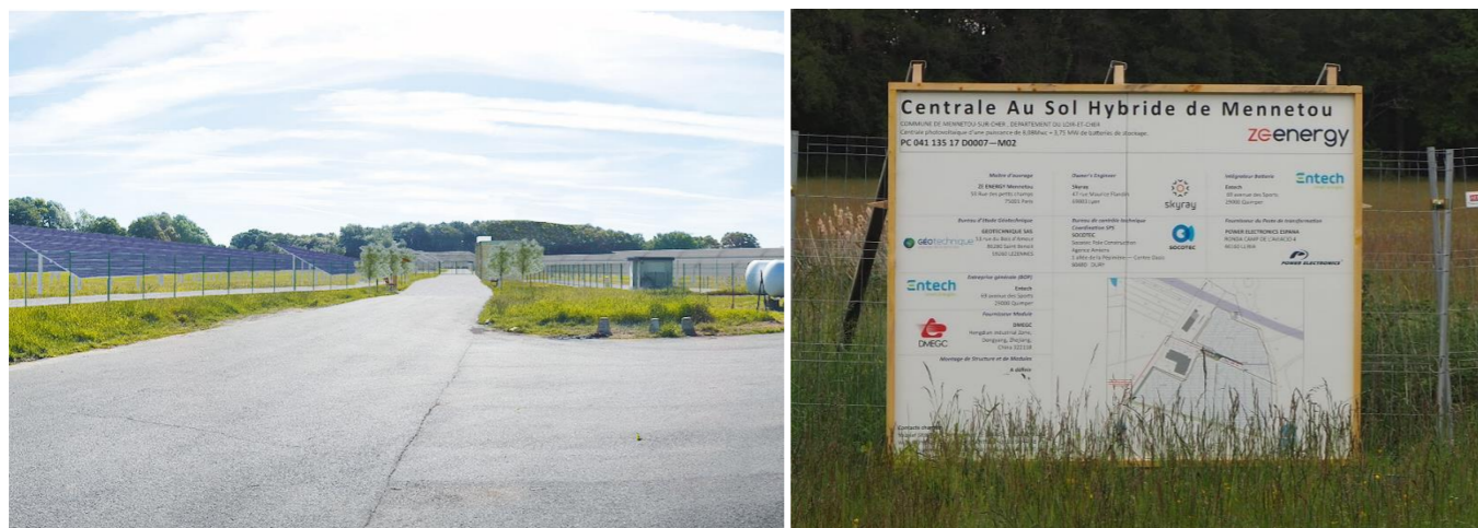
Photo 34 : La centrale photovoltaïque en cours de construction (source : ZeEnergy ; AEPE Gingko)
