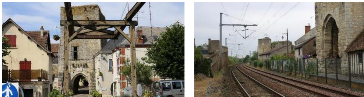
Photo 59 : Tour sud au pied du canal de Berry à gauche ; voie ferrée au pied du coteau à droite
