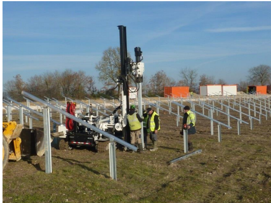
Photo 100 : Mise en place de support de panneaux
