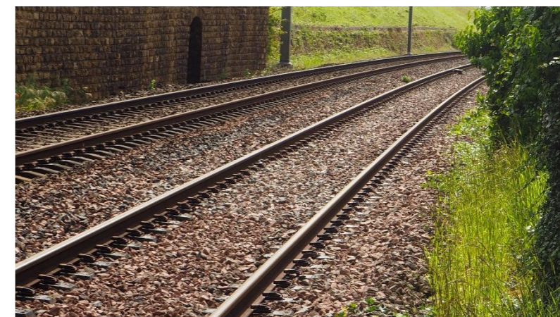
Photo 31 : La voie ferrée Vierzon – Saint-Pierre-des-Corps depuis le bourg de Mennetou-sur-Cher (source : AEPE Gingko)
