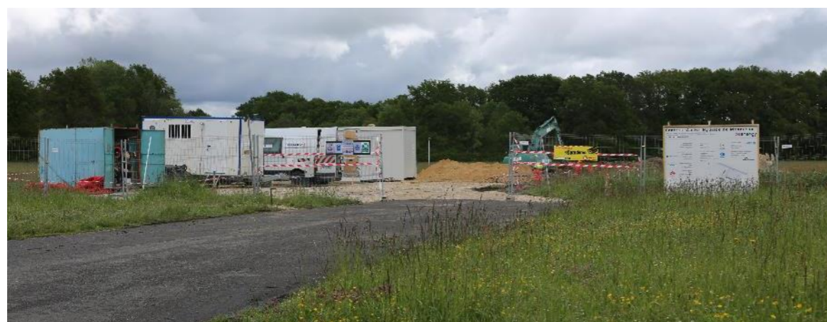
Photo 82 : Chantier de construction de la centrale photovoltaïque de la zone d'activité du Gaudet (mai 2021)
