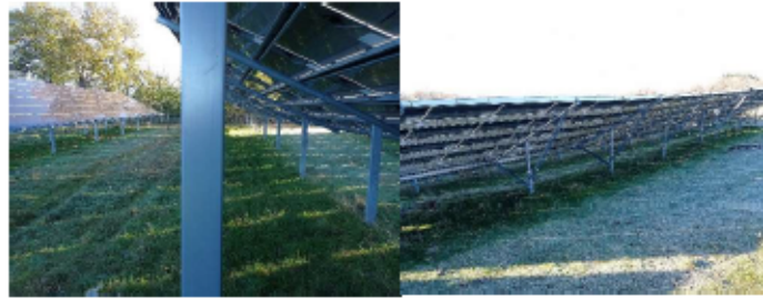
Illustration 5 : Photographies du site de Braize (gauche) et de Marmanhac (droite), montrant l'absence de gelées sous les panneaux.
