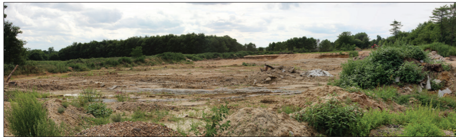
Fosse d'excavation en cours de comblement
