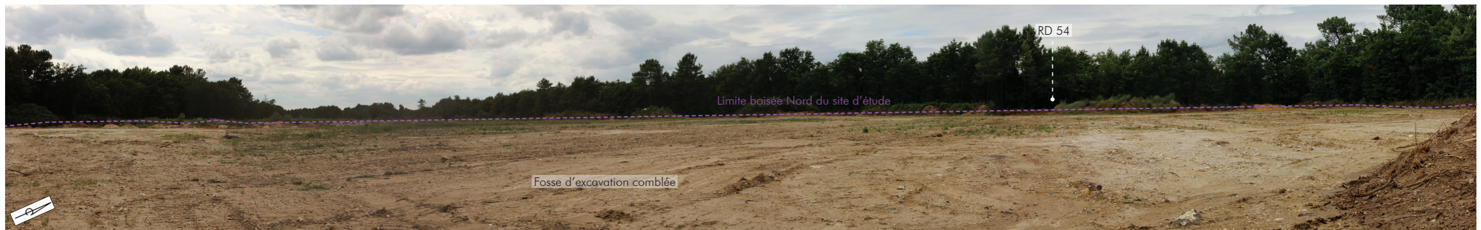
14 - Zone remblayée, Sud-Est
