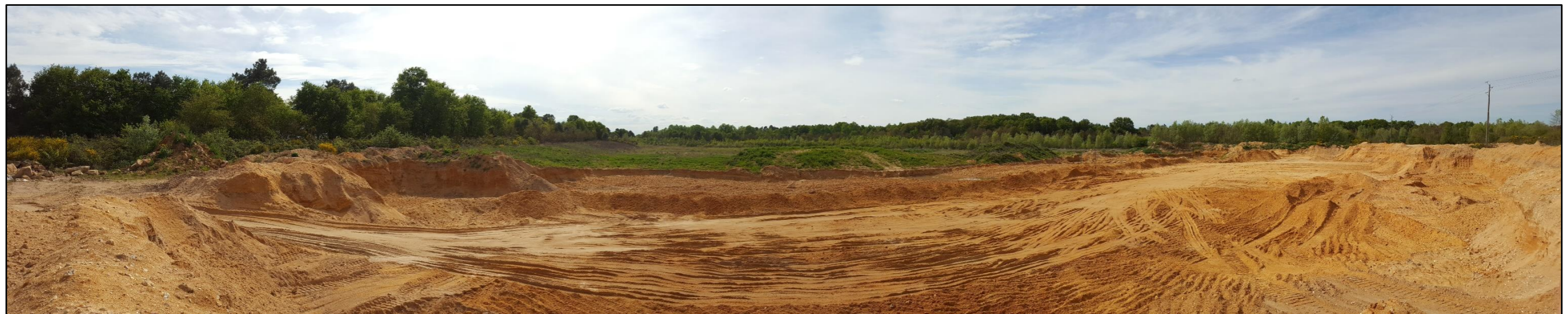
Illustration 9 : Prise de vue n°2 depuis la partie en exploitation du site (Source : EREA Ingénierie – mai 2017)
