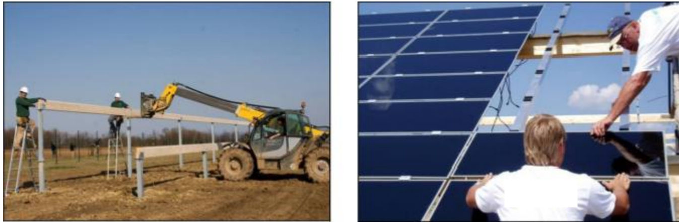
Illustration 23 : Montage des structures porteuses et des modules
