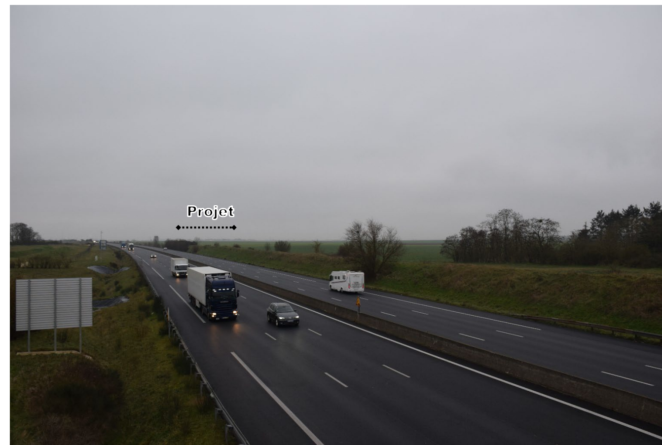
Figure 93 : La section nord-est de l'A10 (© ATER Environnement, 2023)
