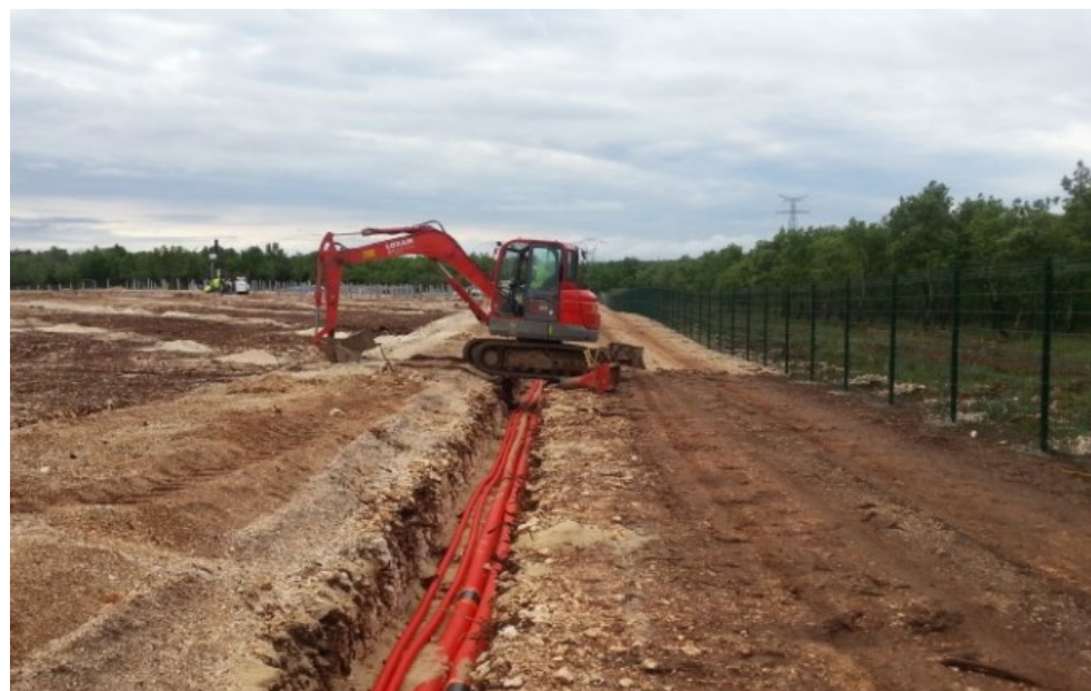
Figure 84 : Exemple d'enfouissement de câbles électriques (source : URBA 411, 2023)
