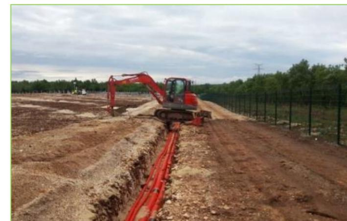
*Photographie 5 - Exemple de tranchée pour la mise en place des câbles électriques (source : ECO-STRATEGIE)*
