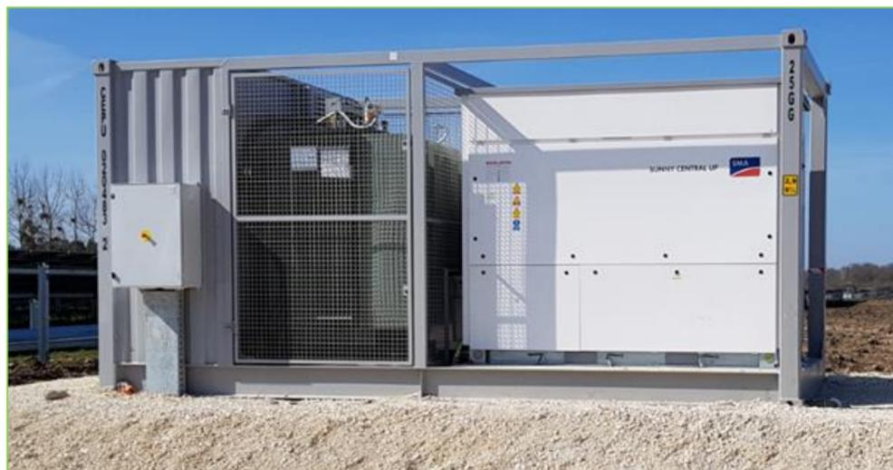
Photographie 2 - Illustration d'un poste de transformation (source : PHOTOSOL)
