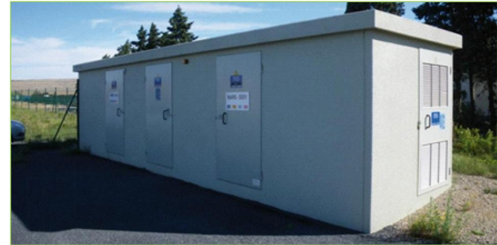
Photographie 1 - Illustration d'un poste de livraison – ici sans la teinte gris-vert qui sera retenue pour le poste de la centrale de Thenay (source : PHOTOSOL)
