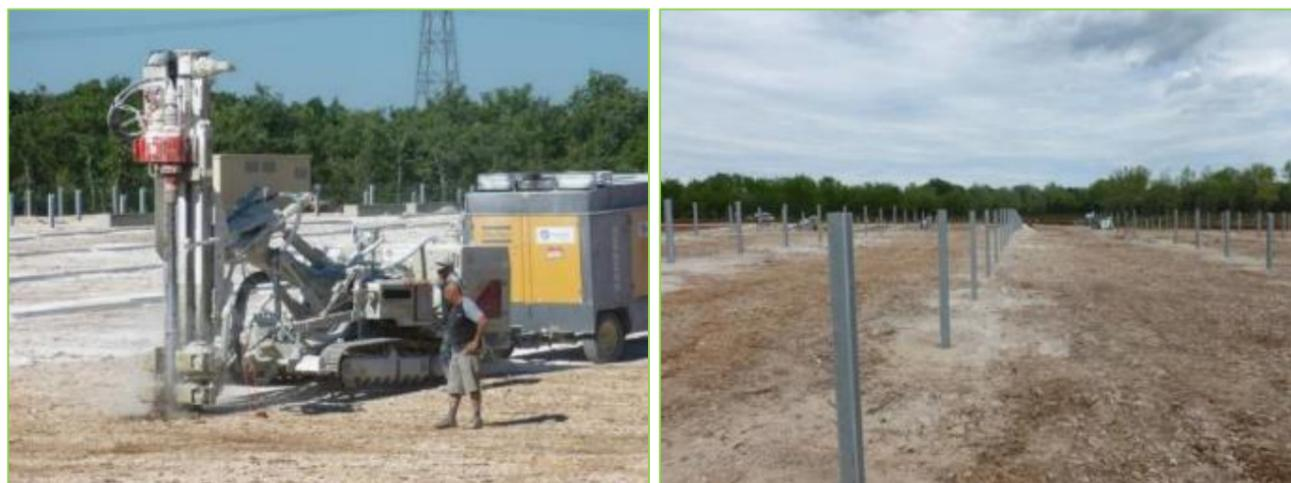
*Photographie 4 – Illustration du battage des pieux (source : PHOTOSOL)*
