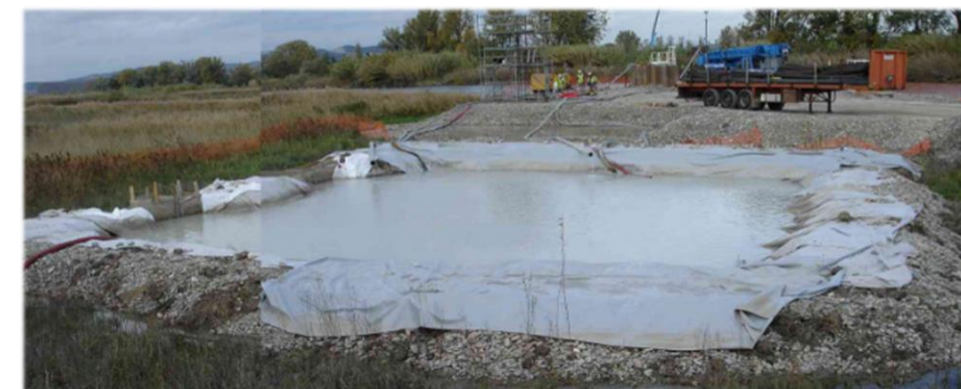
Photographie 78 - Bassin provisoire de décantation des MES et autres polluants (Source : ADEV Environnement)
