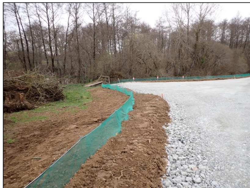
Photographie 73 - Illustration de la clôture anti-retour « amphibien » (sans rampe sur cet exemple)
