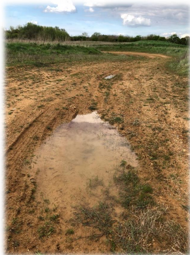
Photographie 74 - Exemple d'ornière fonctionnelle laissée en l'état (haut) et à restaurer (en bas)
