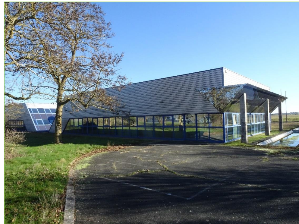
Photographie 34 – Bâtiment présent en partie sud-ouest de l'AEI (source : ECO-STARTEGIE, le 09/02/2022)
