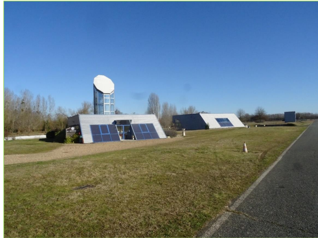
Photographie 40 – Bâtiments liés au circuit automobile et au bar – restaurant Le club House) situés entre 10 et 60 m au nord-ouest de l'AEI (source : ECO-STARTEGIE, le 09/02/2022)
