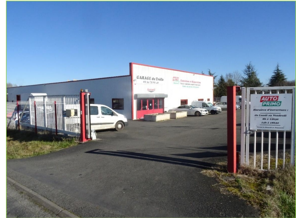
Photographie 42 – Bâtiment commercial (garage automobile) situé à environ 200 m à l'ouest de l'AEI (source : ECO-STARTEGIE, le 09/02/2022)
