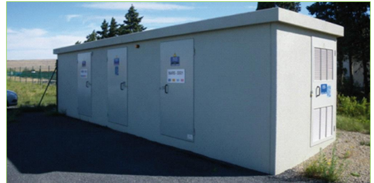
Photographie 2 - Illustration d'un poste de livraison – ici sans la teinte gris-vert qui sera retenue pour le poste de la centrale de Thenay (source : PHOTOSOL)
