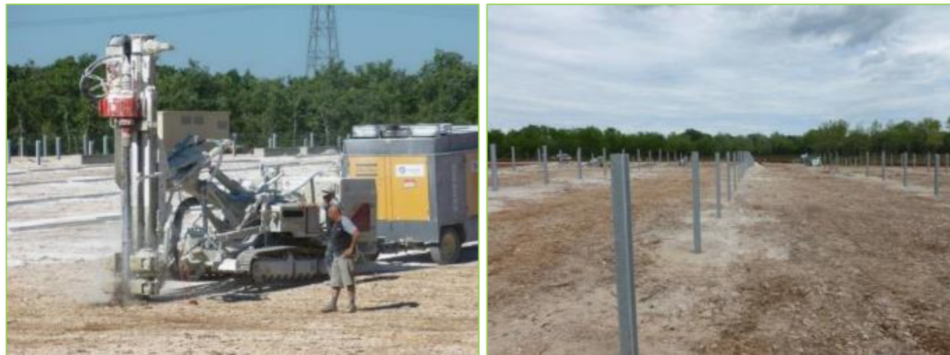
Photographie 6 – Illustration du battage des pieux (source : PHOTOSOL)
