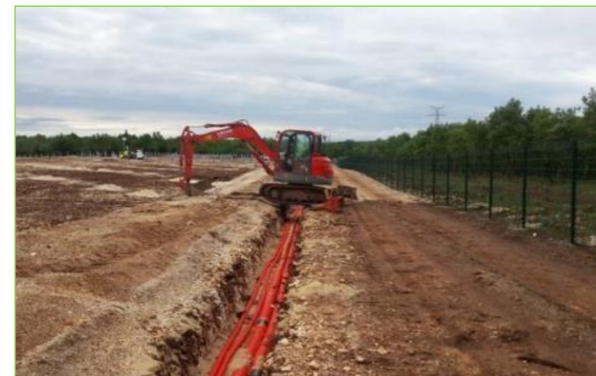
Photographie 7 - Exemple de tranchée pour la mise en place des câbles électriques (source : ECO-STRATEGIE)
