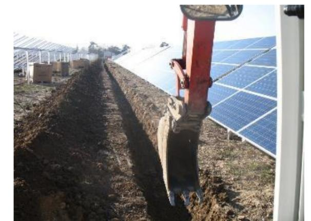
Photo 56. Exemple de tranchée entre deux tables photovoltaïques
