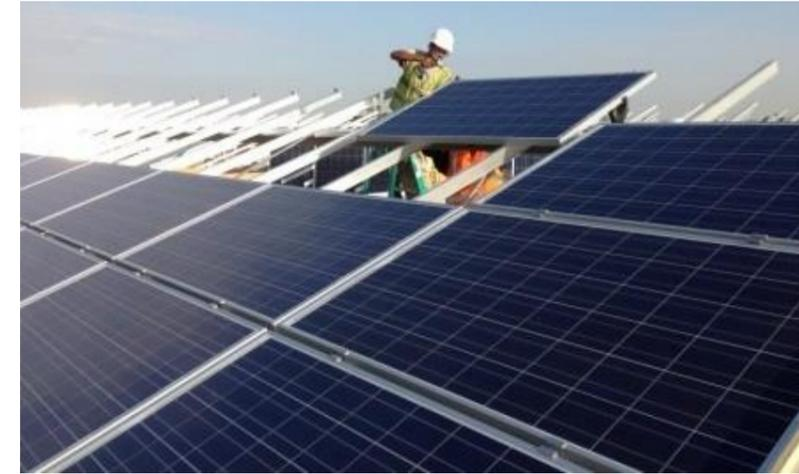
Photo 55. Exemple de mise en place des panneaux sur les structures
