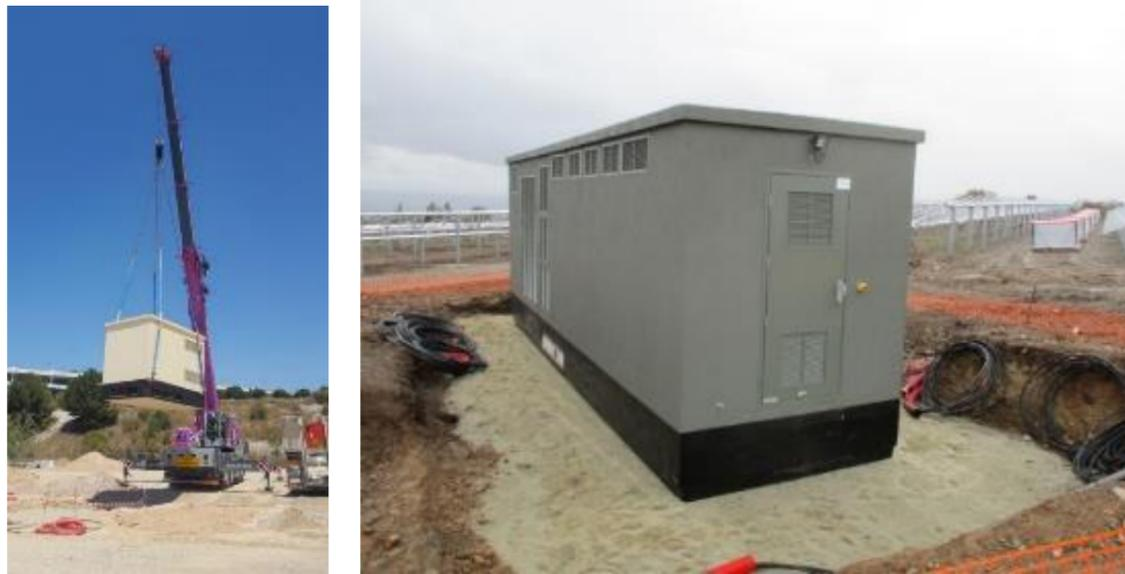
Photo 57. Installation d'un poste électrique
