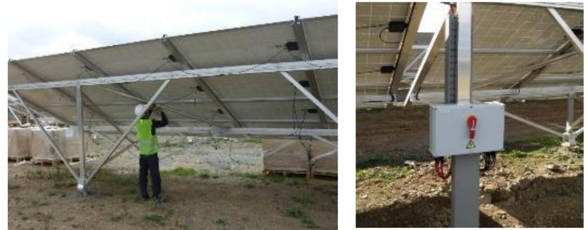
Photo 58. À gauche : Câblage des panneaux – À droite : Boîtier de raccordement
