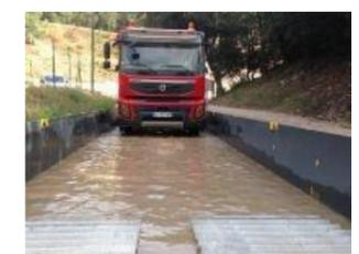
Plateforme de nettoyage des roues
