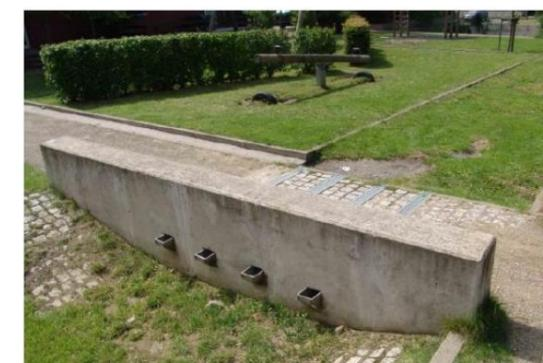
Photo 9: Noue infiltrante à revêtement pavé à joints non cimentés, barrée par un mur de soutènement reliant cette noue à la suivante par un dispositif de trop-plein. Quartier du Kronsberg, Hanovre. Source photo: Valérie Mahaut
