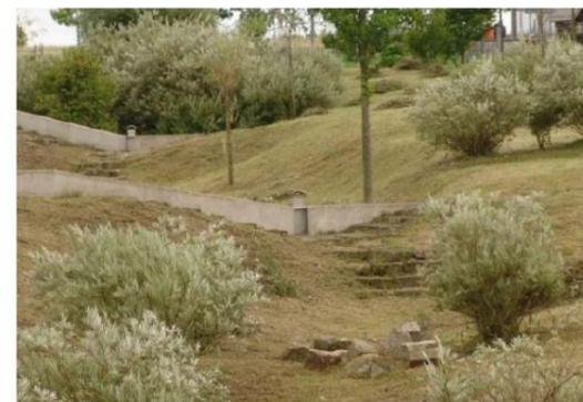
Photo 8: Noue en pente scindée en plusieurs biefs par des murets formant un barrage avec un dispositif de vidange dans le quartier du Kronsberg, Hanovre, Allemagne. Source photo: Valérie Mahaut
