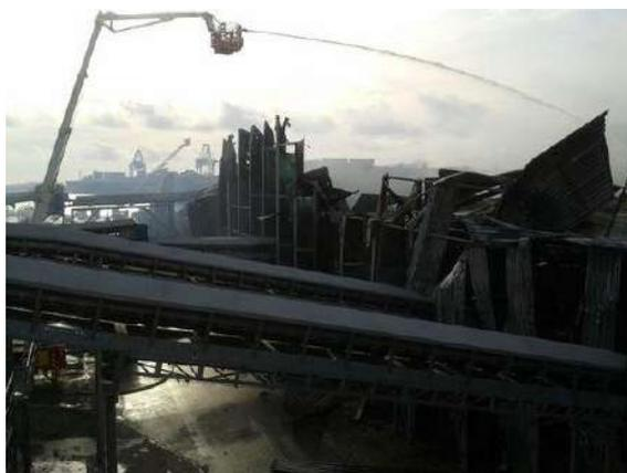
ces derniers ; la chute de matériaux de charpente enflammés met le feu à 2 fosses de déchets ménagers (27 000 m<sup>3</sup> sur 20 m d'épaisseur) vers 6h30.
