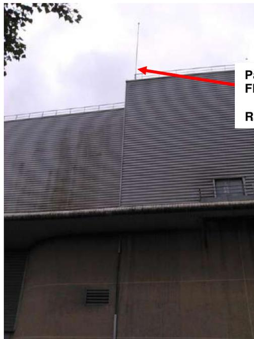
Paratonnerre à dispositif d'amorçage FRANKLIN France ST ELME SE12.
