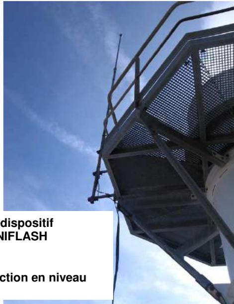
Paratonnerre à dispositif d'amorçage IONIFLASH BENJAMIN
