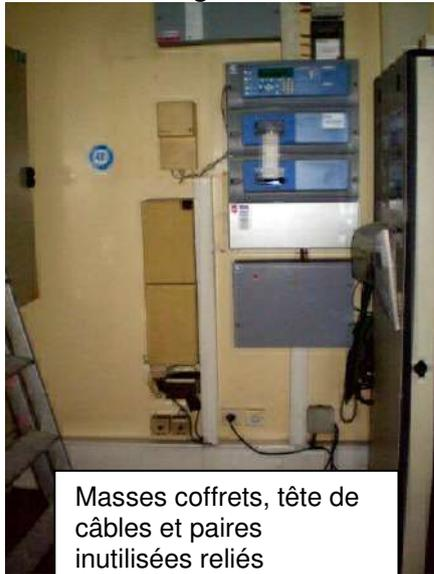
Masses coffrets, tête de câbles et paires inutilisées reliés ensemble au réseau des masses
