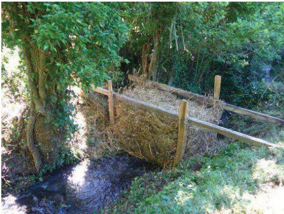
Exemple de filtre à gravier installé entre la pêcherie et le ruisseau longeant le plan d'eau (dans le cas d'un plan d'eau en dérivation)
