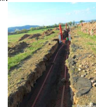
Photo 7 : Tranchée pour câblage
