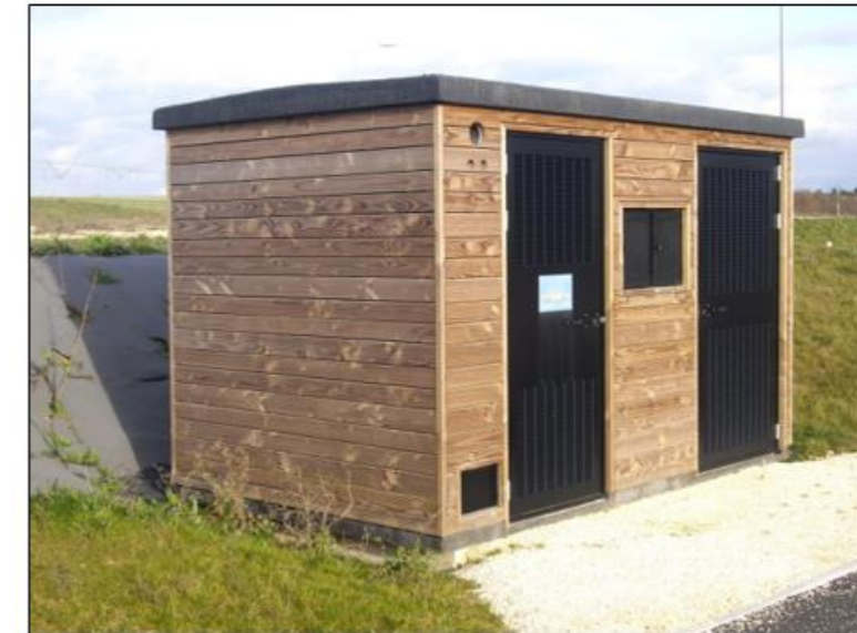
Illustration 8 : Exemple de poste de livraison
