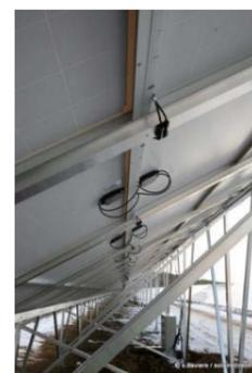
Photo 8 - Câblage sous les modules
