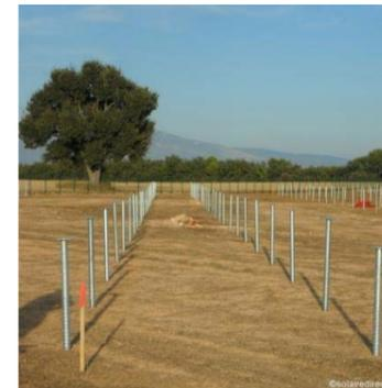
Photo 3 : Vis d'ancrage
