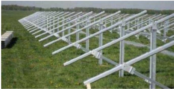
Photo 1 : Structures de support sans modules
