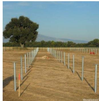
Photo 4 : Vis d'ancrage
