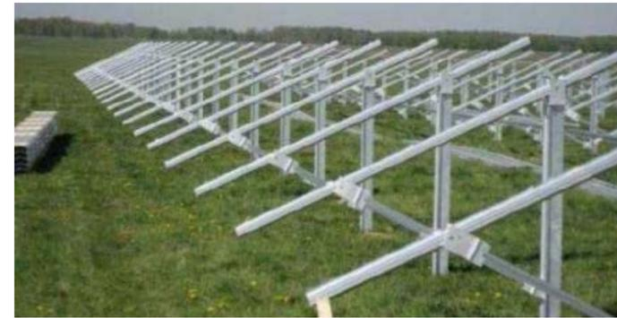
Photo 2 : Structures de support sans modules
