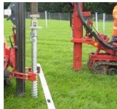
Photo 5 : Machine de vissage
