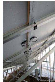
Photo 9 – Câblage sous les modules
